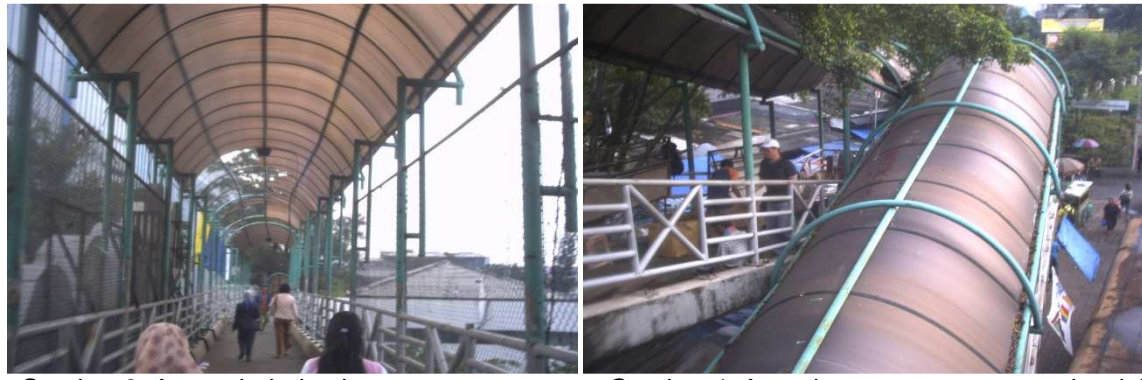
Gambar 3. Atap robek dan lampu penerangan
