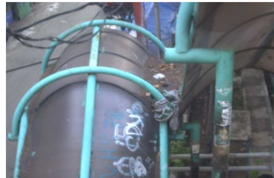
Gambar 14. Sampah disela-sela konstruksi atap
