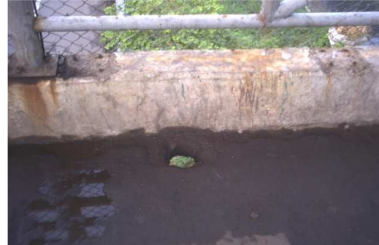
Gambar 12. Lubang pembuangan yang berbahaya
