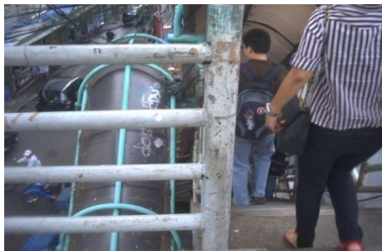
Gambar 13. Sampah disela-sela konstruksi atap
