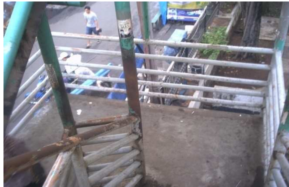
Gambar 9. Karat dan debu pada pegangan
