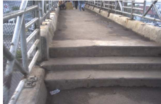
Gambar 8. Tangga pada sambungan jembatan
