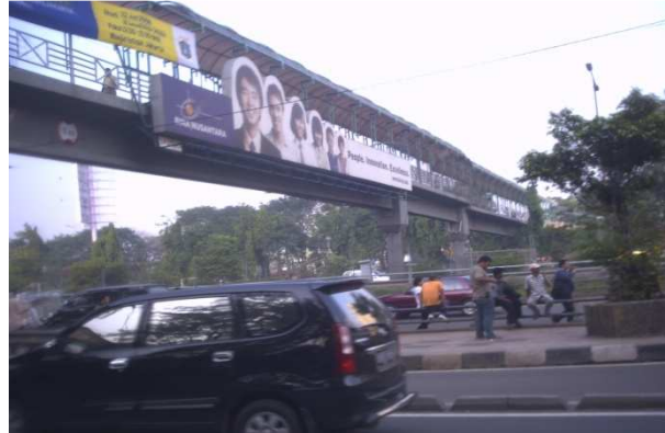
Gambar 1. Jembatan penyebrangan dekat kampus I Untar Jakarta
