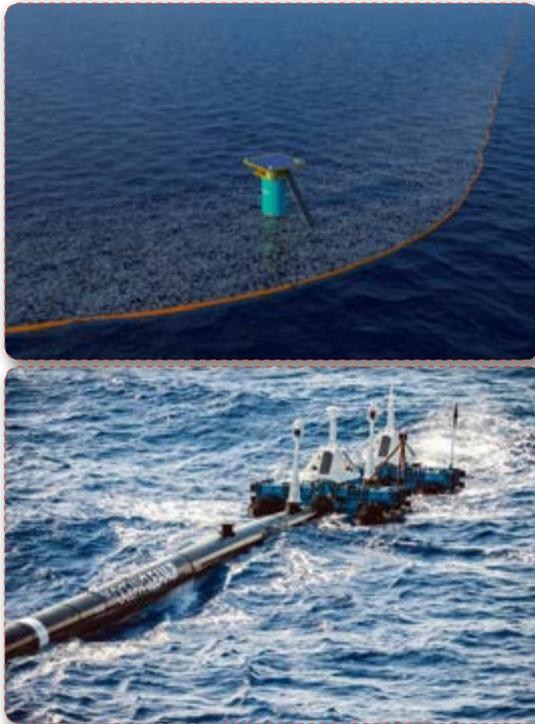
TOC menggunakan pipa HDPE dengan diameter lebih dari 100 cm sepanjang 600 meter dalam satu rangkaian sistem untuk mengumpulkan sampah laut.
