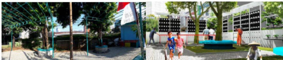
Gambar 13. Progress Realisasi Usulan Desain pada Ruang Publik RW. 08, Tanjung Gedong (Sumber: Tim PKM, 2019)
