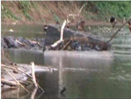
Gambar 5. Bekas Pondasi Jembatan Lama
