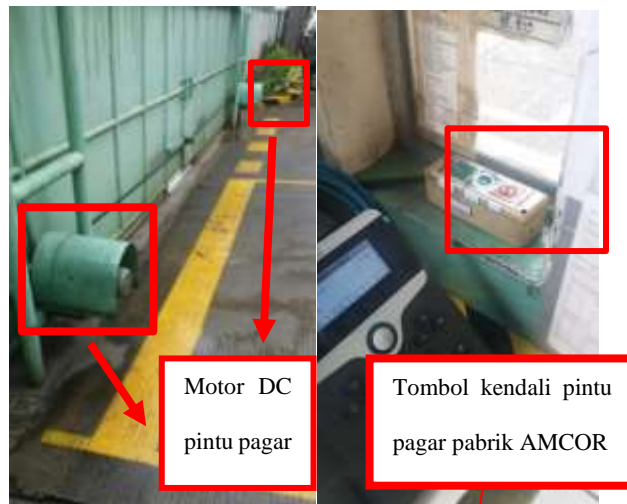
■ Gambar 1. Hasil Survei Pengamatan Pintu Pagar Pabrik AMCOR
