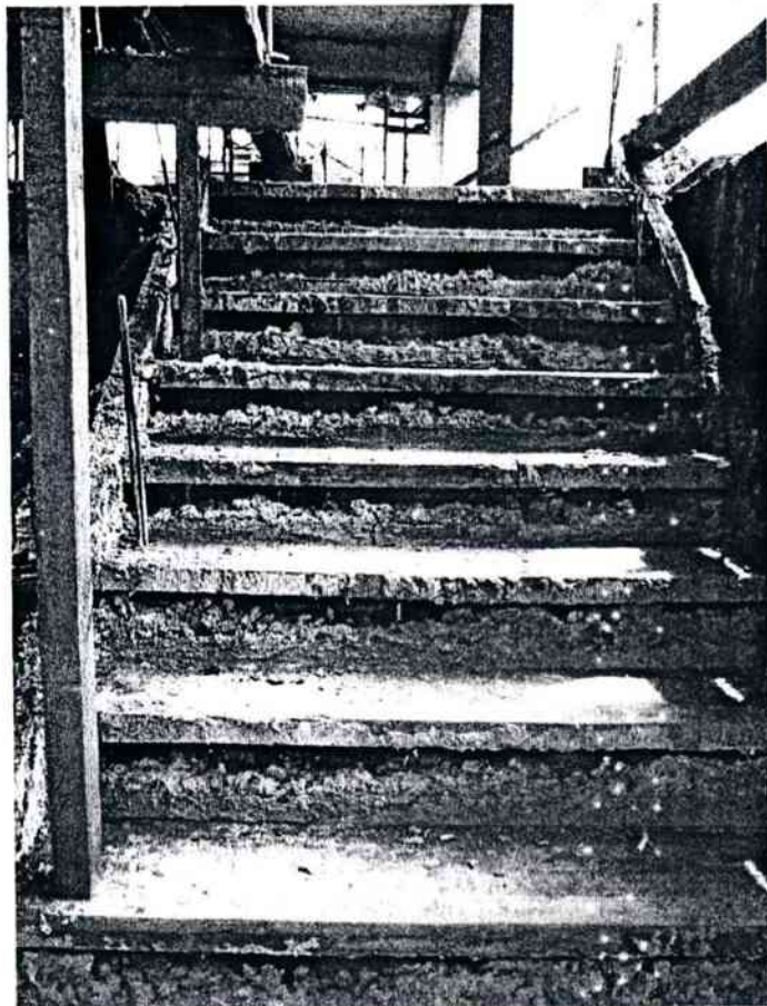
Gambar LG.4. Pekerjaan Struktur Tangga
