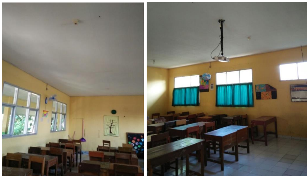
Gambar 1. Ruang kelas SMP N 2 Cibinong sebelum retrofit lampu
