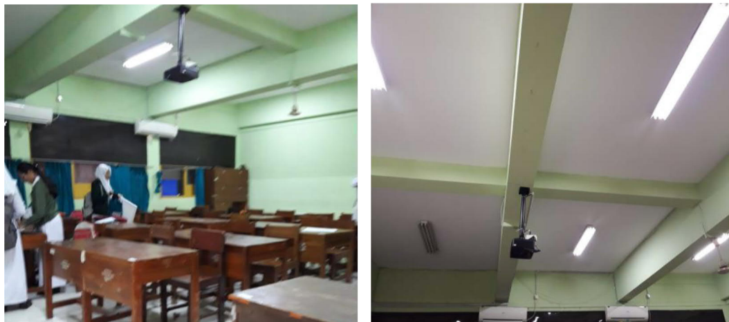
Gambar 1. Pencahayaan ruang kelas SMA N 23 (eksisting) dengan Lampu TL-8
