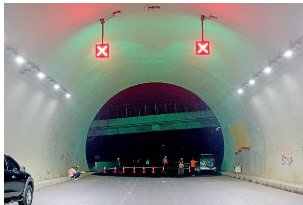
Gambar 6. Zona exit terowongan Cisumdawu (Sumber: Dokumen Pribadi 2021)
