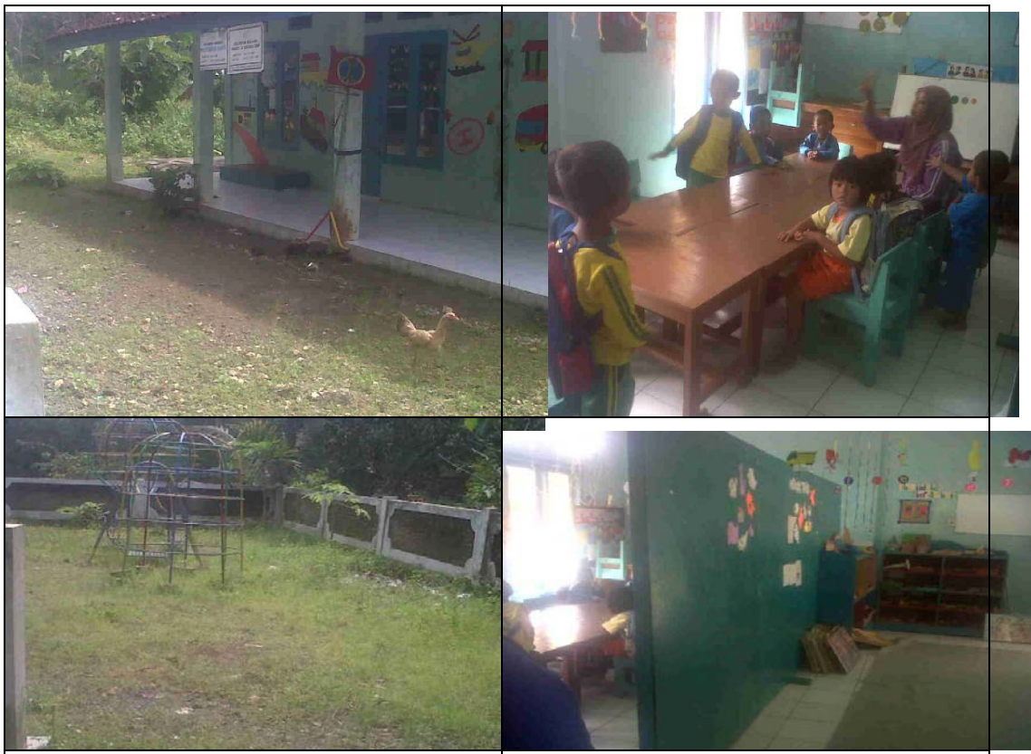
Gambar 1. Kondisi di PAUD Mutiara Hati Sumber: Dokumentasi Tim Pengabdian
