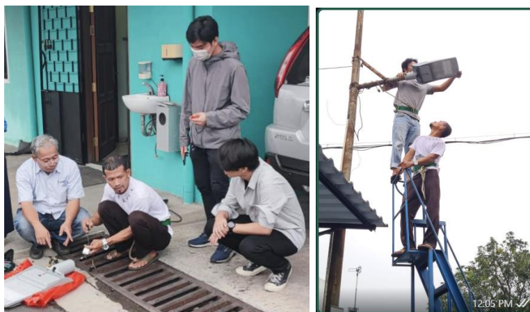
Gambar 11. Proses memasang luminer LED PJU di lokasi mitra.
