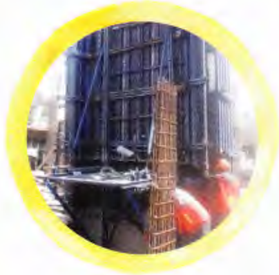
KATEGORI METODE KONSTRUKSI 4-Hours Shear Wall Formwork System
